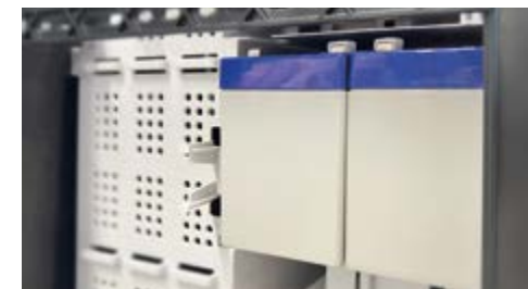
Batterie tampone da 7Ah (opzionali)
